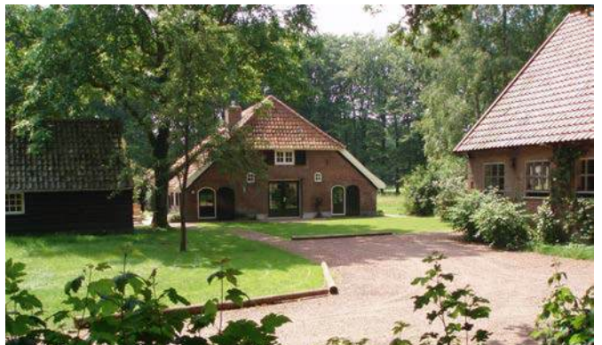
Impressie erf aan de weg (foto hoveniersbedrijf de Bosboom)
