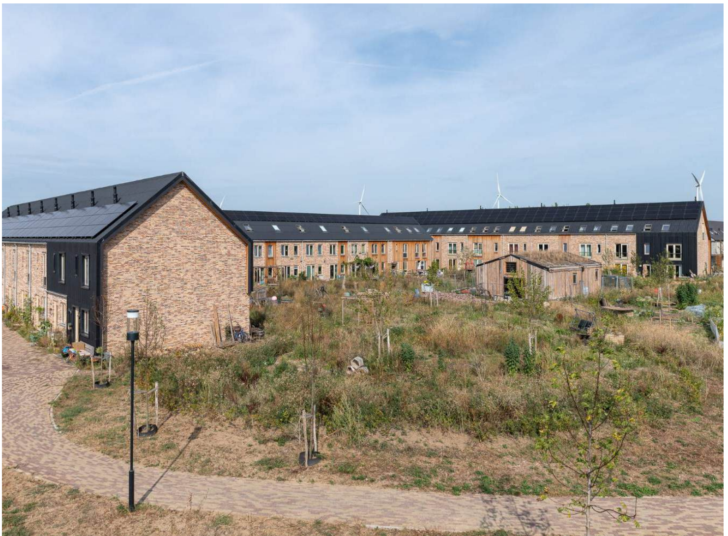
Impressie Zuiderveld (Fotograaf: Walter Frisart FOTOwerk)
