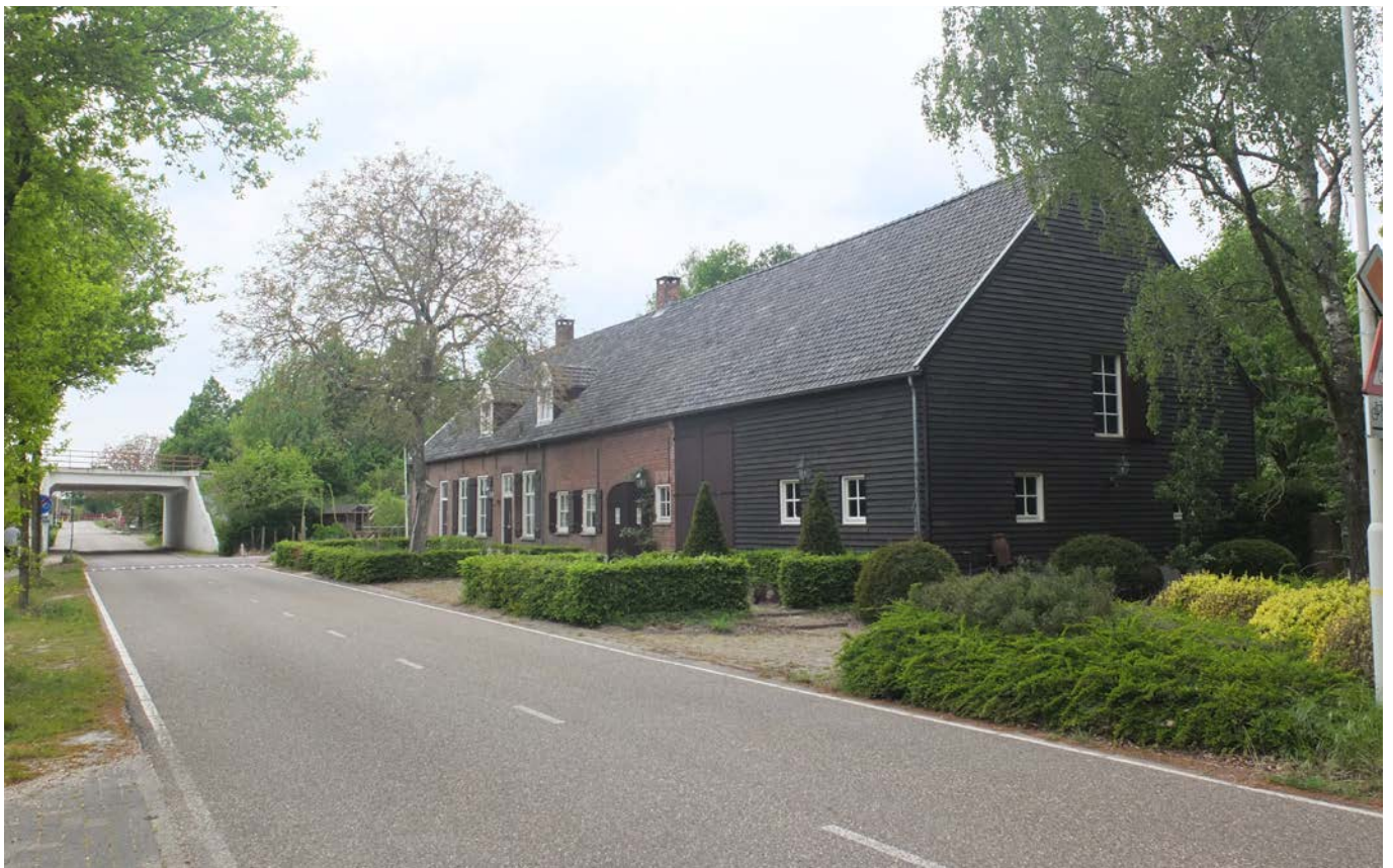
Bestaande lang gevel boerderij aan de Eindhovensedijk De Kemmer
