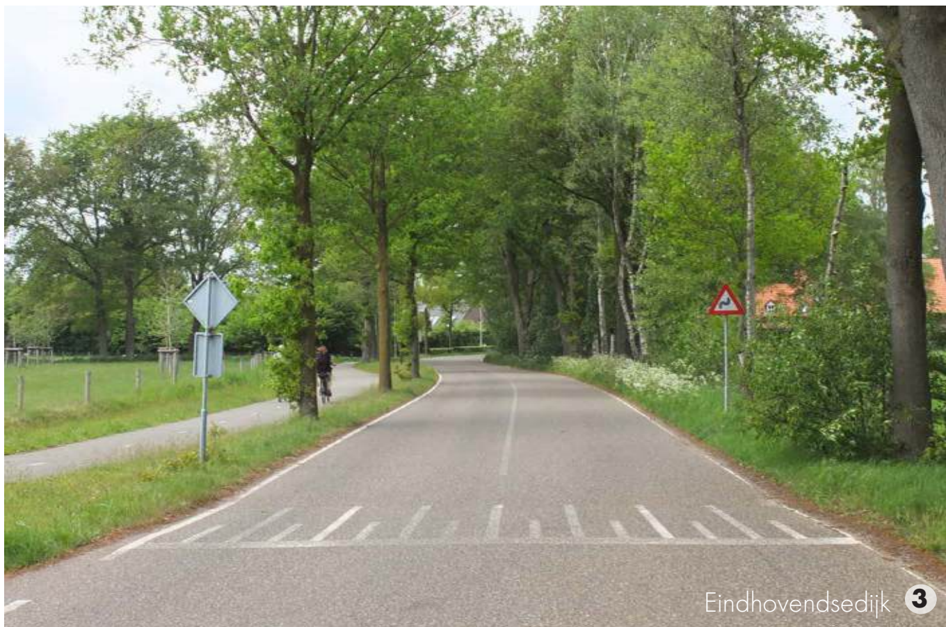
Eindhovensedijk met vrijliggend fietspad aan één kant
