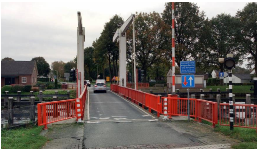
Figuur 1.2: Brug Heuvel; smalle ophaalbrug.
